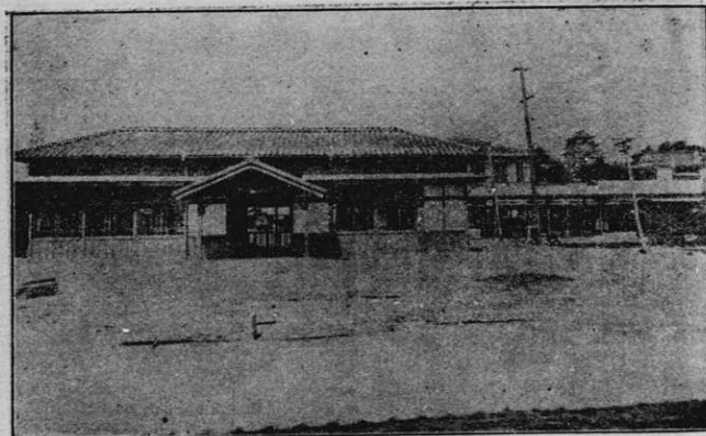
福山福備間の工事
